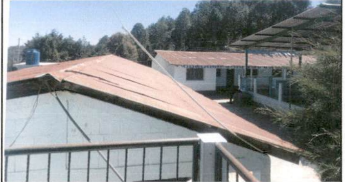
Foto 2: Continúa Imégen acerca de la reparación del techo de lámina
