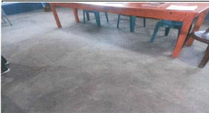
Foto 3: Sustitución del piso por cerámica
