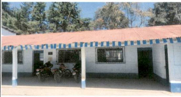
Foto1: Imégen acerca de la reparación del techo de lámina
